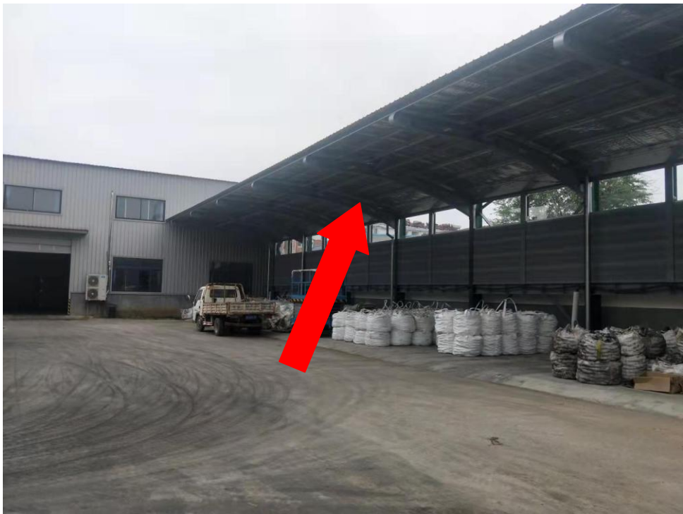
公司西面隔音墙
